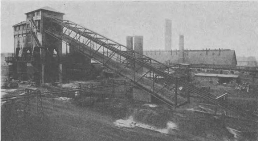
Abb. 122. Gaserzeugungsanlage mit Hängebahn.
