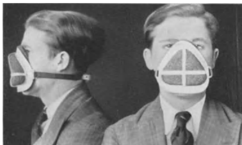
Abb. 26. Atemschützer aus Gummischwamm, Filterleistung ungenügend.
