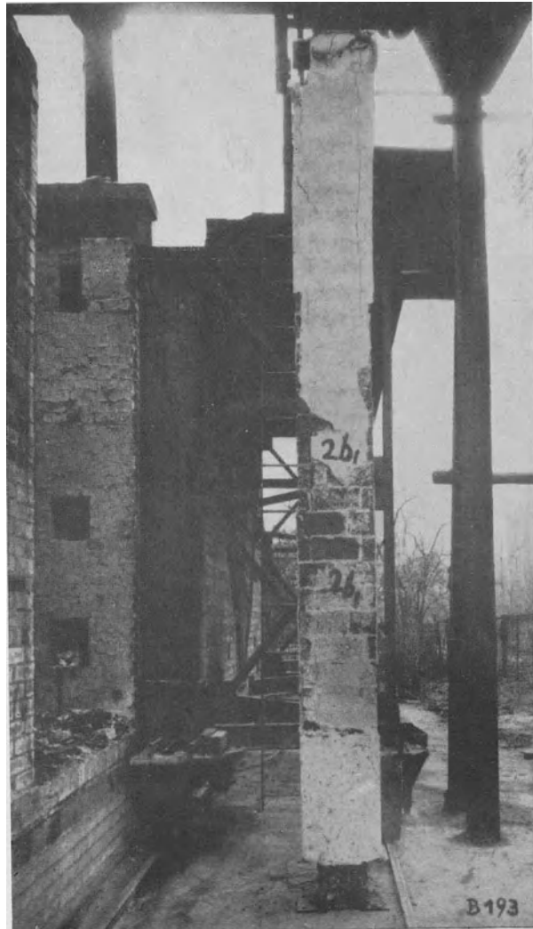
Bild 12. Brandversuche mit ummantelten Stahlstützen (ohne Kern). Ummantelung: Bimsstein 6,5 cm dick mit Putz. Widerstandsfähigkeit: 180 Minuten. Höchste Temperatur am Stahl rund 750°.
