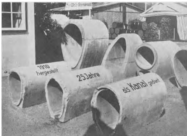
2. Betonrohre nach 25jähriger Verwendung
