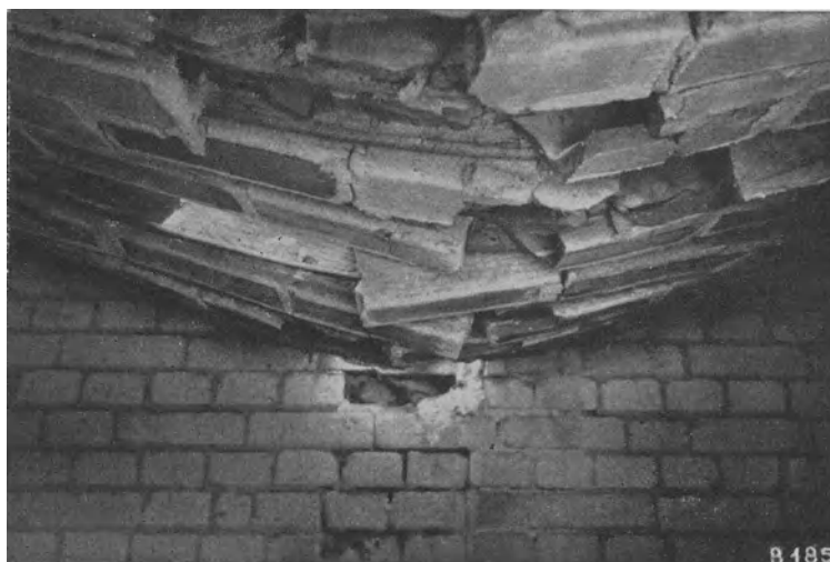
Bild 4. Untersicht einer belasteten Steineisendecke nach dem Versuch.
