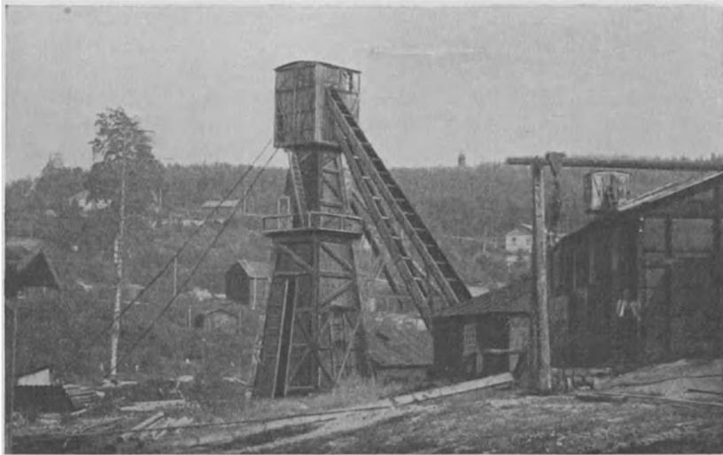
Abb. 69. Außenansicht eines Bohrturmes mit zwei nebeneinander angeordneten Förderhaspeln.
