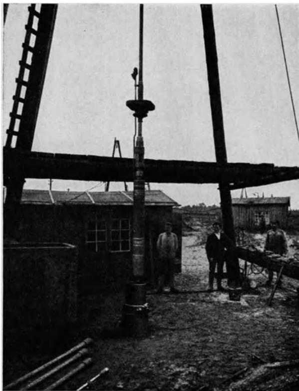
Abb. 125. Senkpumpensatz im Betrieb.
