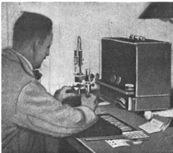
Fig. 4. Nachprüfen der Maße mit Hilfe von Flüssigkeitslehre.
