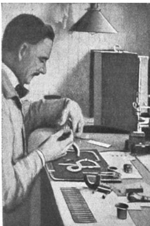
Fig. 1. Polieren des Außendurchmessers einer Lehre.
