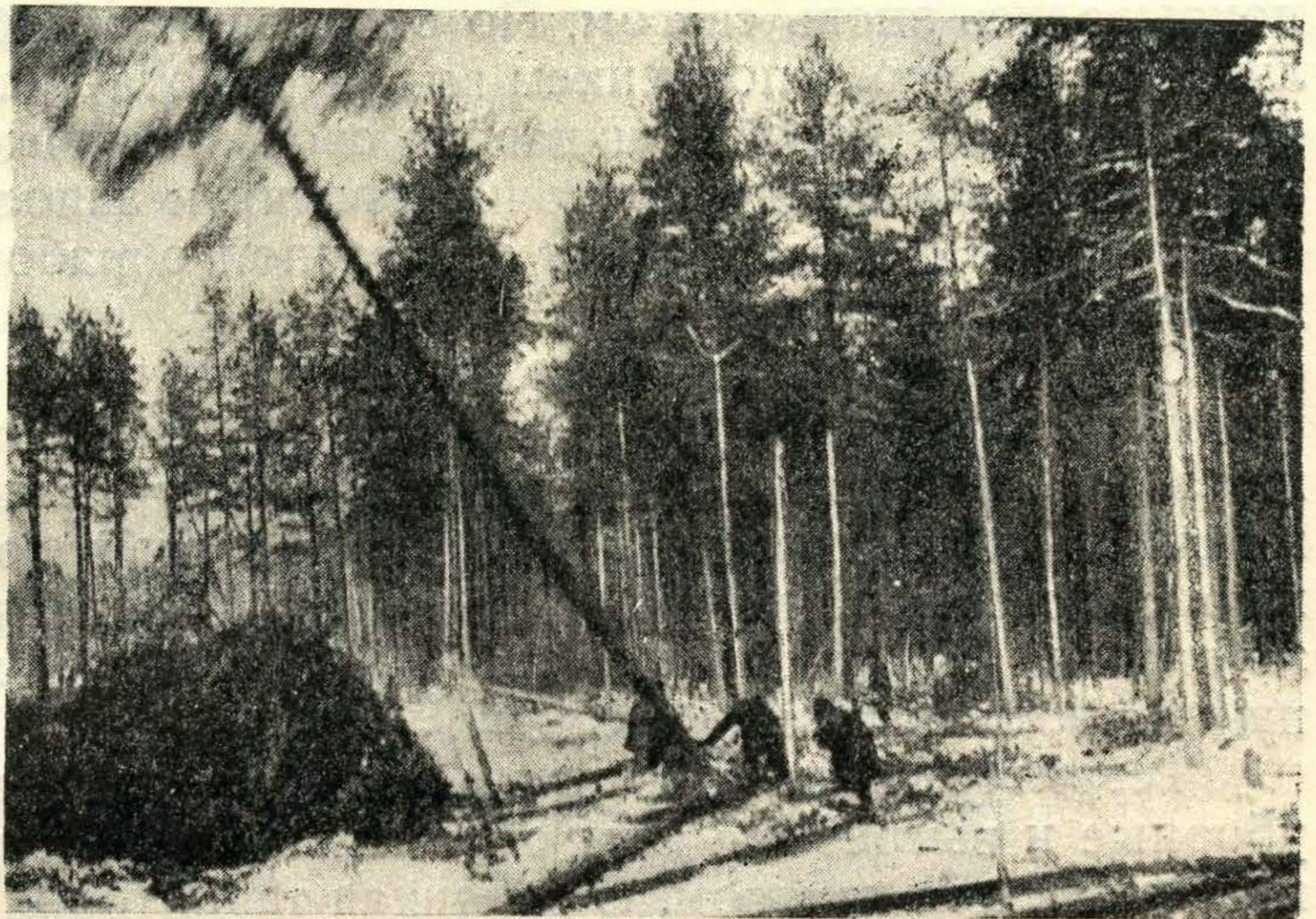
Фиг. 99. Вырубка леса на трассе Водопроводного канала.
