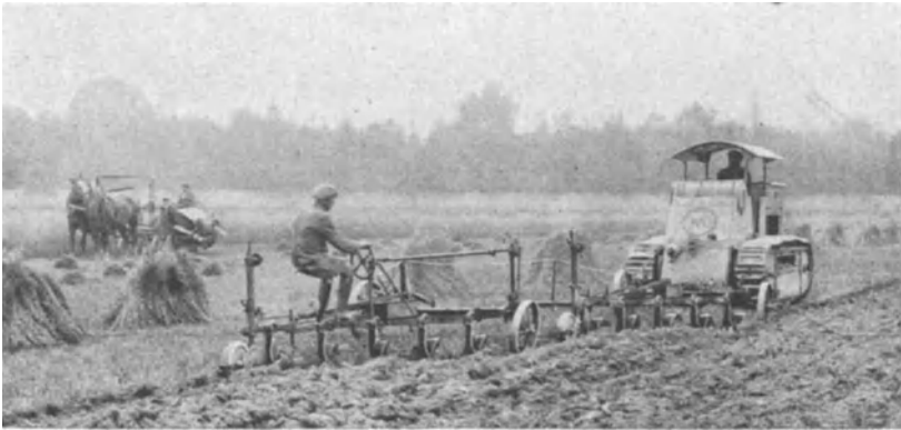
Abb. 1. Stoppelsturz mit gekuppelten Schälpflügen der Fa. R. Sack, Leipzig
