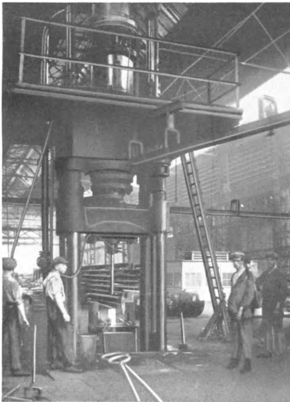
Abb. 8. Röhrenlochprozeß nach System Ehrhardt.
