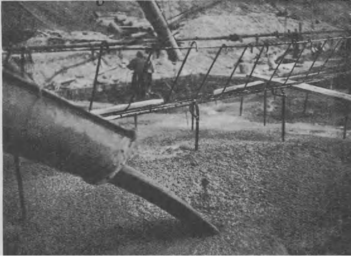
Abb. 39. Grenze zwischen Guß- u. Flußbeton. Vergl. V in Abb. 34 (15,5% Wassergehalt).
