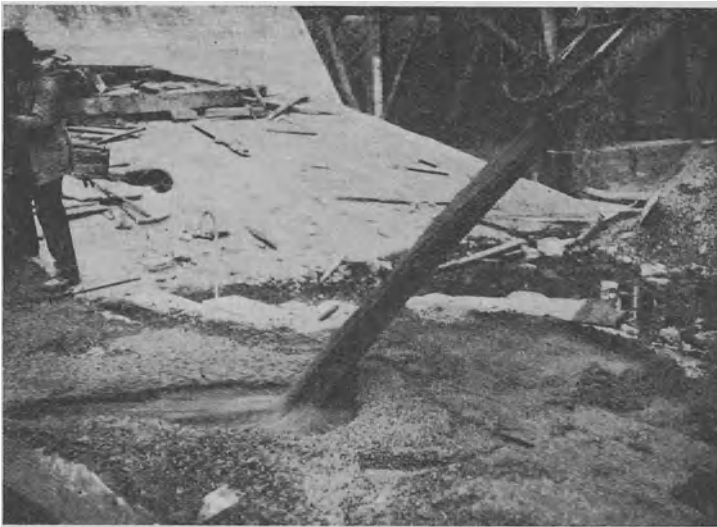
Abb. 40. Flußbeton. Vergl. VI in Abb. 34 (17% Wassergehalt).
