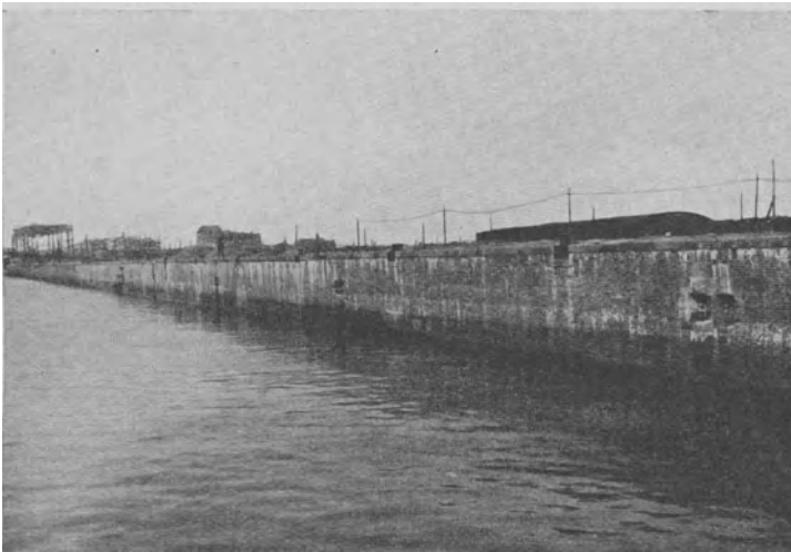
Abb. 6. Ansicht der fertigen Mauer.
