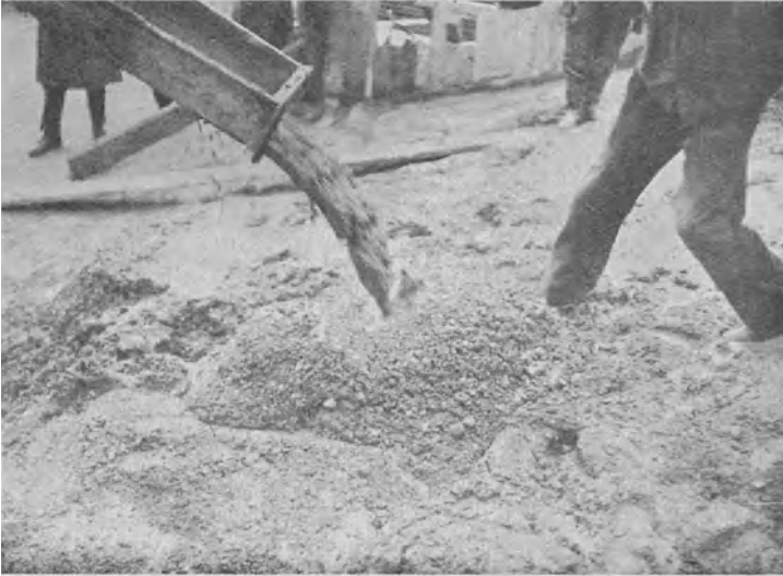
Abb. 37. Weichbeton. Vergl. III in Abb. 34 (13% Wassergehalt).
