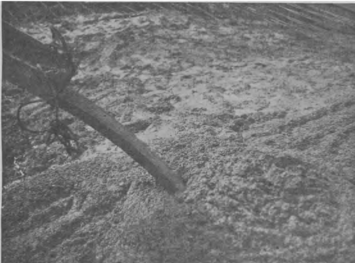
Abb. 12. Gußbeton mit geringstmöglichem Wasserzusatz.
