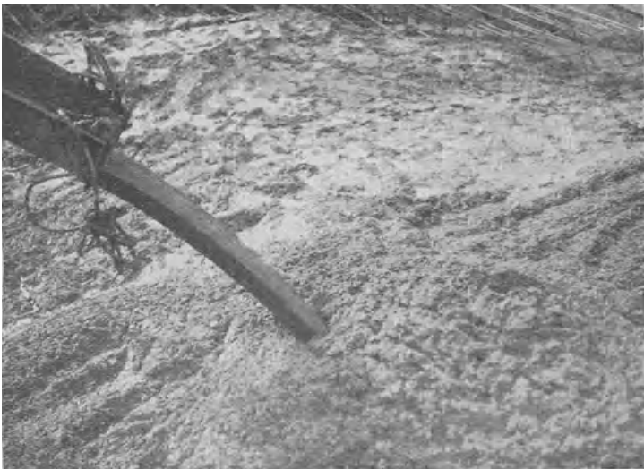
Abb. 38. Richtiger Gußbeton. Vergl. IV in Abb. 34 (14% Wassergehalt).
