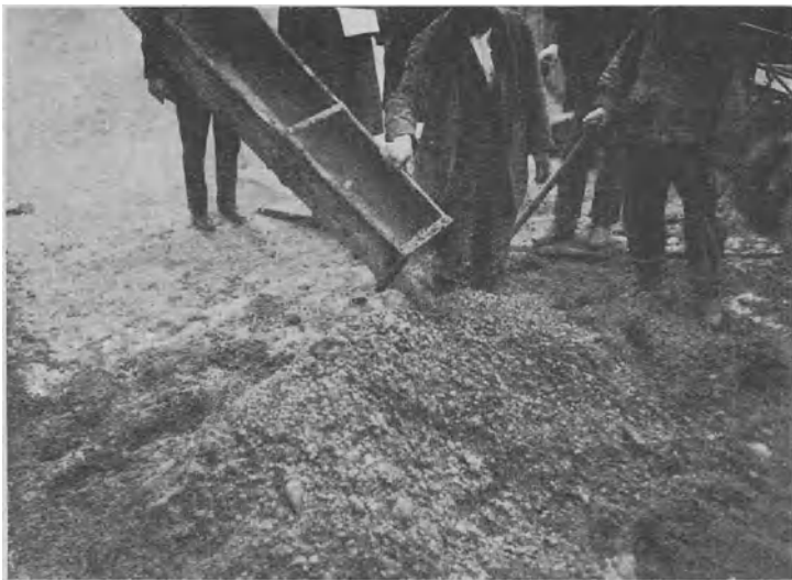
Abb. 36. Richtiger Stampfbeton. Vergl. II in Abb. 34 (11% Wassergehalt).
