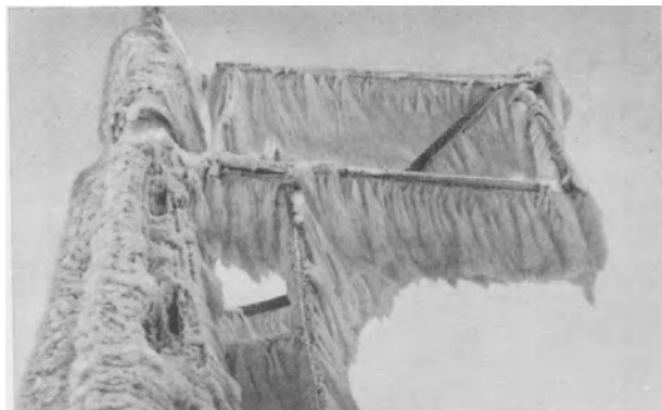
Abb. 13. Aufgang zum Windmesser mit Rauheis besetzt.
