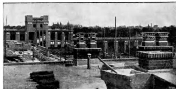
Fig. 63. Abluftrohre auf dem Dach des westlichen Laboratoriengebäudes.
