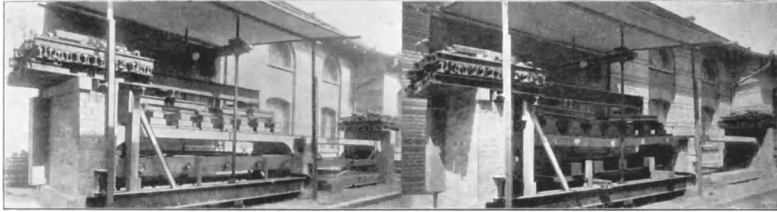
Deckenprüfung mittels Presse.
