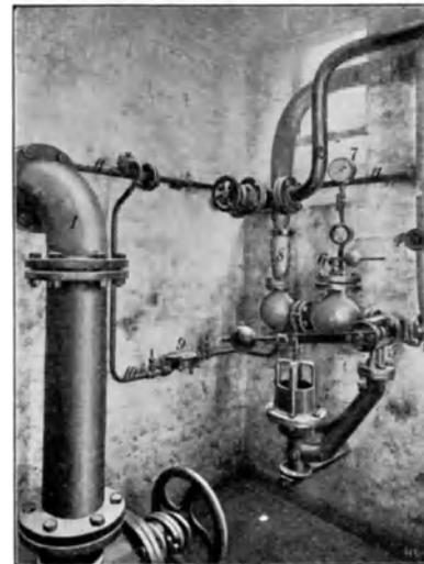
Fig. 155\*\*\*) Röhrenkeller zwischen dem Reinigungsbassin und dem Sammelbassin.
