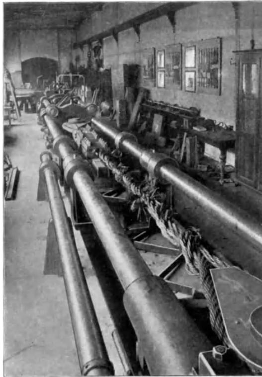
Fig. 242. Zugversuch mit einer Seilbefestigung.
