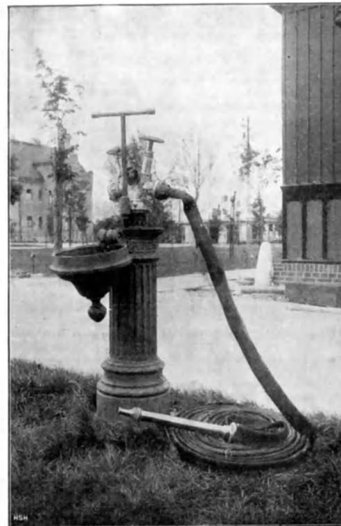
Fig. 133 und 134. Oberflurhydranten.
