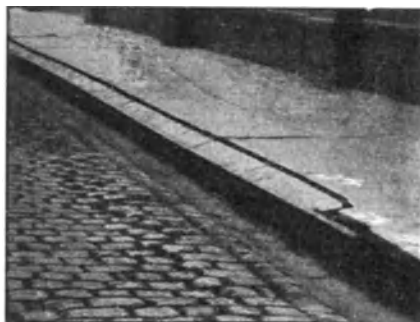
Fig. 156. Quer zur Straßenachse gepflasterter Bordstein. Nähe der Muldenmitte.
