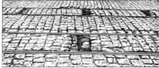
Fig. 128. Erweiterung der Pflasterfugen an den Spurstangen und Krümmung derselben an den Laschen.
