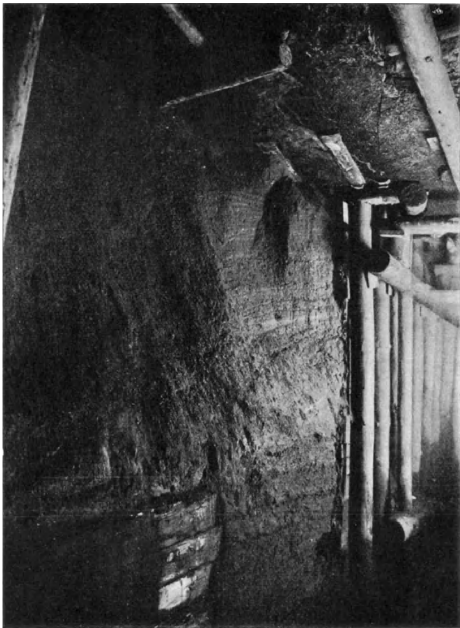
Fig. 114. Ansicht eines alten verspülten Abbaues.
