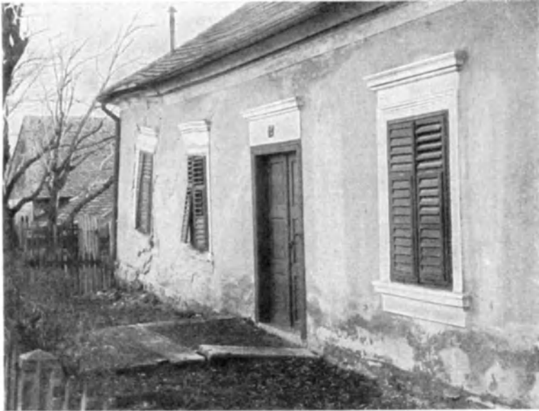
Fig. 172. Bergschäden an einem Gebäude.
