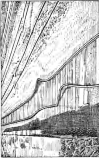
Fig. 123. Pressungserscheinungen in Geleisen.
