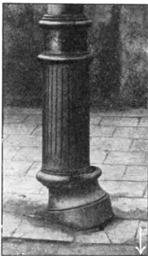
Fig. 155. Mast 100. Nördlich von Kurve S. Zerdrückter Mastsockel, zerstörter Bordstein.
