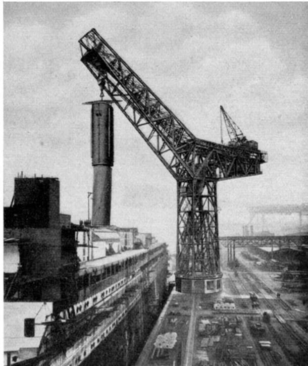
Abb. 860. Turmdrehkran, Blohm & Voß, aufgetoppt.
