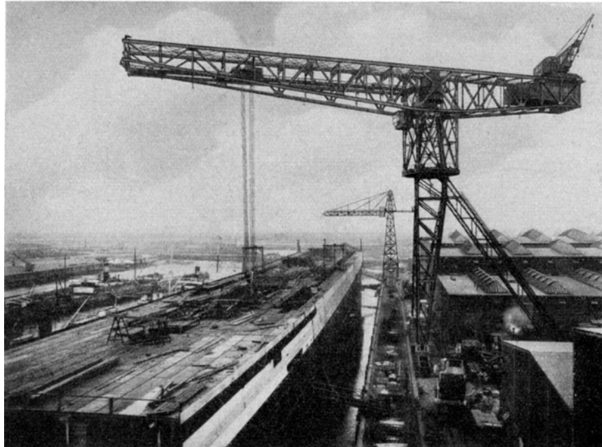
Abb. 863. Fahrbarer und fester Ausrüstungskran. Vulkan-Werke, Hamburg.
