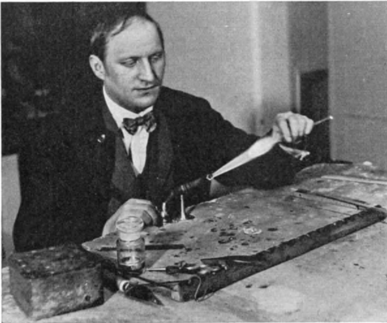
Abb. 37 a, Stad. 2. Anblasen der Kugel an das Thermometerrohr.
