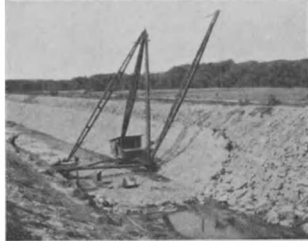
Abb. 224. Skogaby, Abpflasterung des Unterkanals, Blick stromabwärts. (NWK.)
