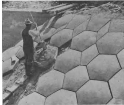
Abb. 228. Abdeckung der Böschung mit Sechseckplatten.
