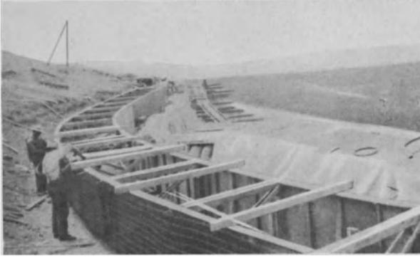
Abb. 246. Eisenbetongerinne fertig zur Torkretierung. (Cement Gun Co., Allentown USA.) Sohlenbreite: 1,75; Tiefe 1,22 m; Wandstärke 5 cm.
