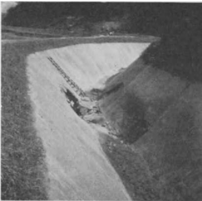
Abb. 220. Sohlen- und Böschungsbruch in einem ausbetonierten Kanal (Ludin).
