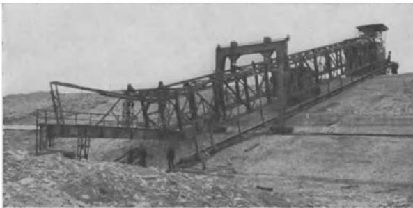
Abb. 234. Böschungsplaniermaschine. (Dingler, Zweibrücken.)
