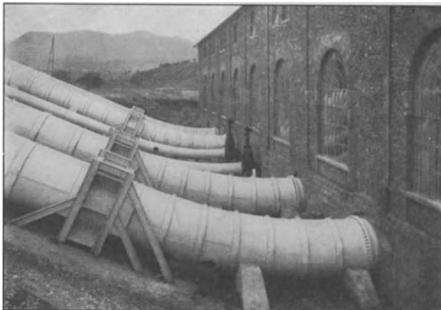
Abb. 310. Ventavon. Verankerung der Fallrohrleitung vor dem Krafthaus (Ludin).
