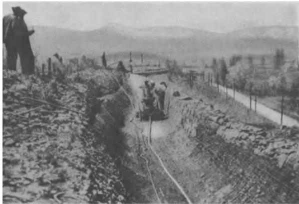
Abb. 240. Hangstrecke eines Bewässerungskanal in Calif. (Cement Gun Co., Allentown USA.) Rechts Trockenmauer. Bewehrung zum Torkretieren ist eingebracht.
