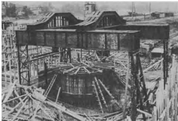
Abb. 485. Blechträger zur Aufnahme der senkrechten Lasten von Generator und Turbine (Kraftwerk Griesheim a. M.).
