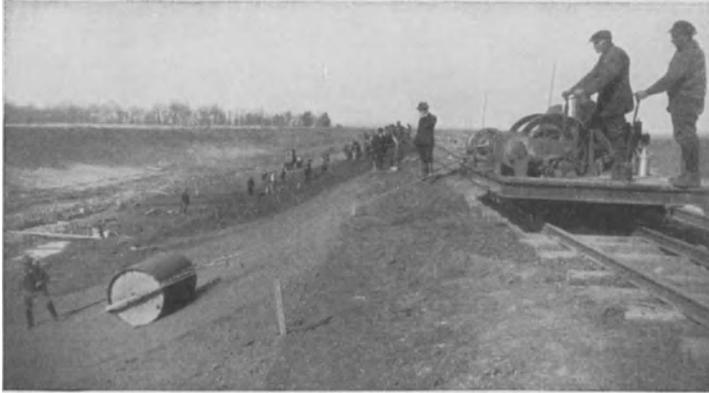
Abb. 219. Einwalzen einer plastischen Böschungsdichtung mit in der Falllinie geführten Walzen.
