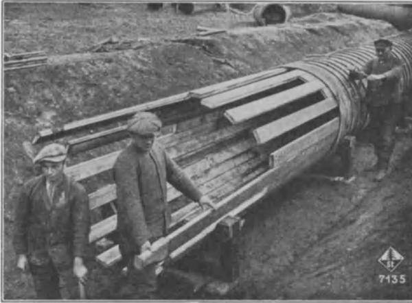
Abb. 347. Turbinenleitung Mylau. Vorstrecken des kontinuierlichen Holzrohres, offen verlegt auf Holzsätteln mit Betonfundamenten.  $d = 1215$  mm, Gesamtlänge 284 m. Druck am unteren Ende 9 m W.S. (Steinbeis u. Kons., Rosenheim.)
