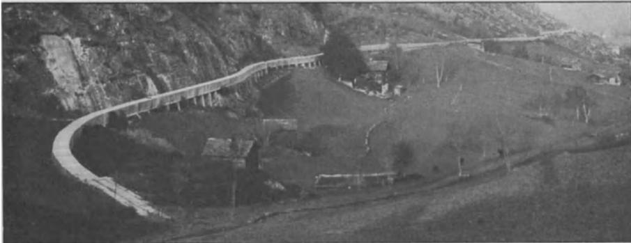
Abb. 247. Eisenbeton-Hangkanal Mörel-Brieg. Blick talaufwärts (Ludin).
