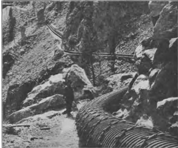
Abb. 349. Holzrohr im Gebirge (Pikes Peak Pow.-Co. bei Victor Col. USA.). (Geolog. Survey 22. Ann. Rep. IV.)
