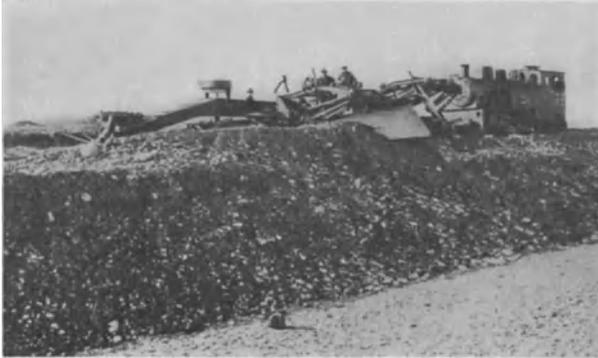
Abb. 233. Planierpflug (Kippenräumer) beim Kanaldammbau Kembs. (Verw.)
