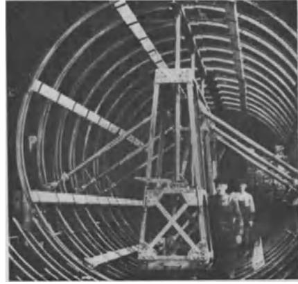
Abb. 281. Deutsche Stahlschalung. *a* Fahr- und klappbares Schalungsgerüst (wird in 4 m Länge von Schalungsmaschine aufgenommen und versetzt). *b* Fertig eingeschaltete Strecke von rd. 150 m (im unteren Drittel Schalung eingesetzt, rechts und links: vor Ansetzen der Schalung). (Ibag - Neustadt/H. = jetzt Stahlschalung Luchterhand & Co.)
