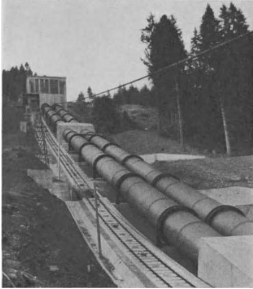
Abb. 299. Schluchsee, Fallrohrleitung des Kraftwerks Häusern (Ludin).
