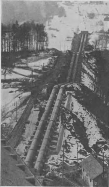
Abb. 297. Fallrohrleitung des Wäggitälwerkes (untere Stufe, Siebnen).
