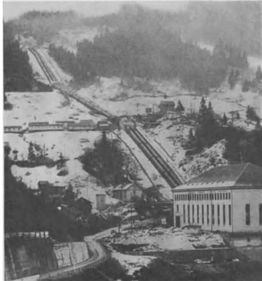
Abb. 298. Fallrohrleitung der oberen Stufe des Wäggitalwerkes (Rempen).
