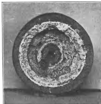
Abb. 100. Durch Kesselstein vollständig zugesetztes Speisewasservorwärmerrohr.
