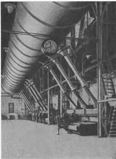
Abb. 245. Kesselhaus mit eisernem Bunker und Beschickungsrohren, ohne zwischengebaute Wiegeeinrichtung.
