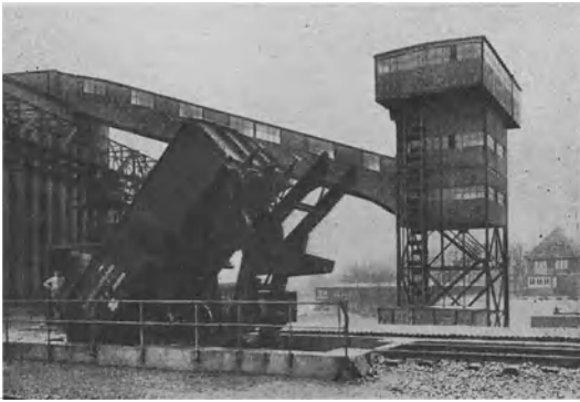
Abb. 239. Wagenkipper, Becherwerk, Übernahmeturm und Gurtförderer.
