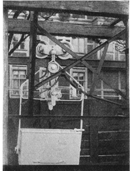
Abb. 129. Entkuppelstelle der Schraubekupplung.
