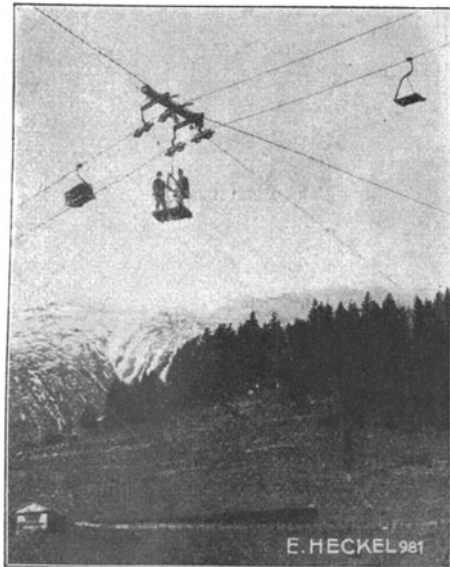
Abb. 450. Aufhängung der Tragrollen an Spannseilen.
