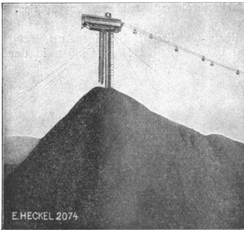
Abb. 352. Turmstation mit Führungsschläuchen.
