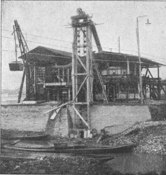
Abb. 183. Uferstation mit Beladekran und Becherwerk.
