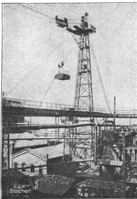
Abb 507. Fester Turm des Kabelkrans auf Zeche Rheinbaben.
