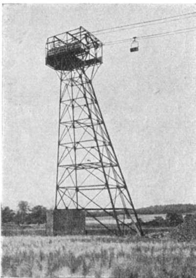
Abb. 340. Umföhrungsstation einer Haldenseilbahn.
