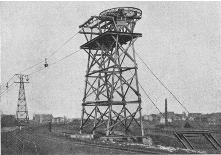
Abb. 180. Endumführungsstation einer Haldenbahn.
