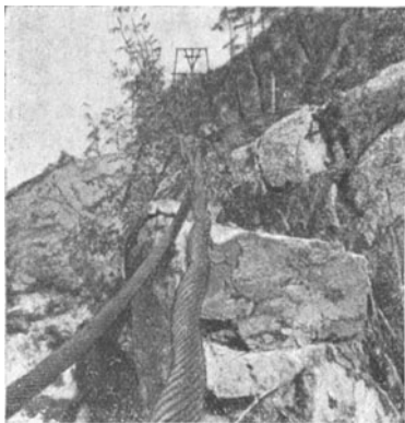
Abb. 538. Verformung eines fehlerhaften Laufseiles.
