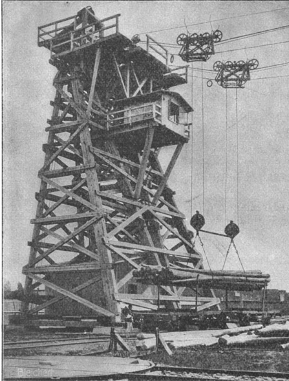
Abb. 500. Maschinenturm eines Doppelkrans.
