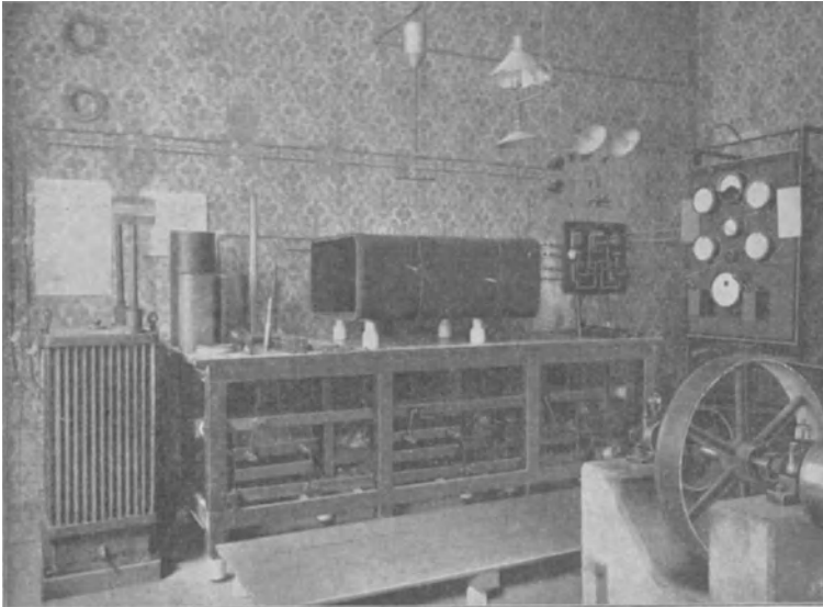
Fig. 11. Prüfstand für elektrische Isoliermaterialien der Firma MEIROWSKY & Co., Köln-Ehrenfeld.
