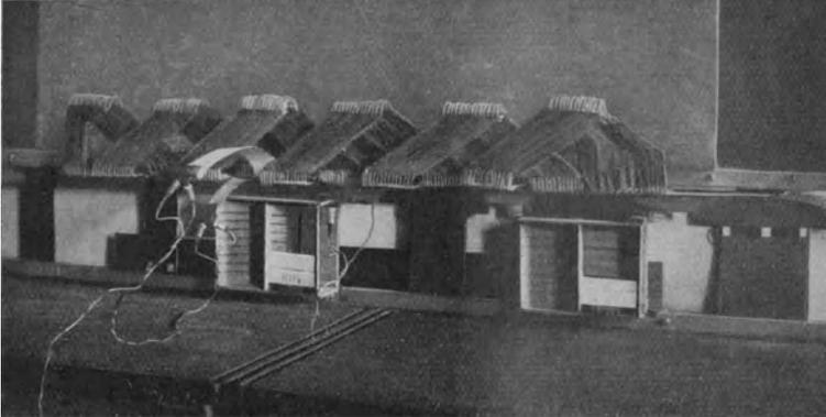
Abb. 20. Modell der Schenkelpolmaschine mit eingebauter einschichtiger „Evolventen-Wicklung“.
