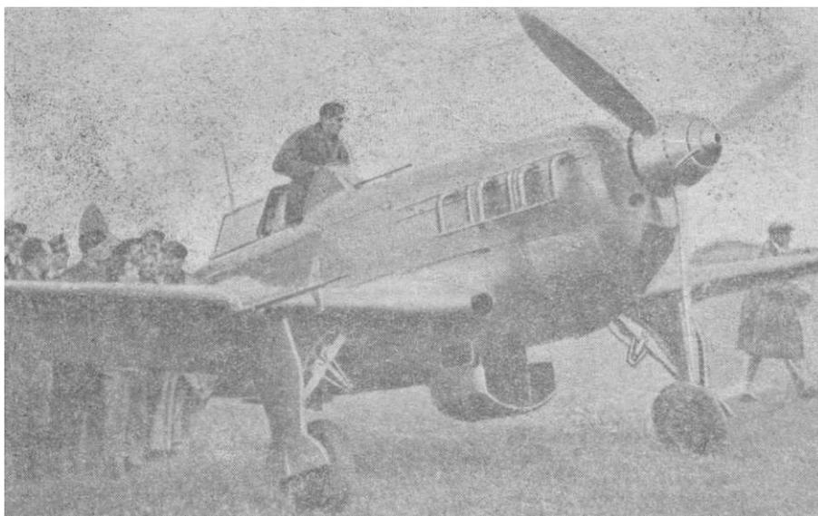
Французский одноместный пушечный истребитель моноплан «Девуатин-513» с мотором жидкостного охлаждения «Испано-Сюиза» в 925 лошадиных сил. Максимальная скорость—480 километров в час на высоте 4850 метров, потолок—11400 метров; вооружение—пушка, стреляющая через винт, и 2 пулемета в крыльях; шасси убирается в полете, конструкция целиком металлическая.
