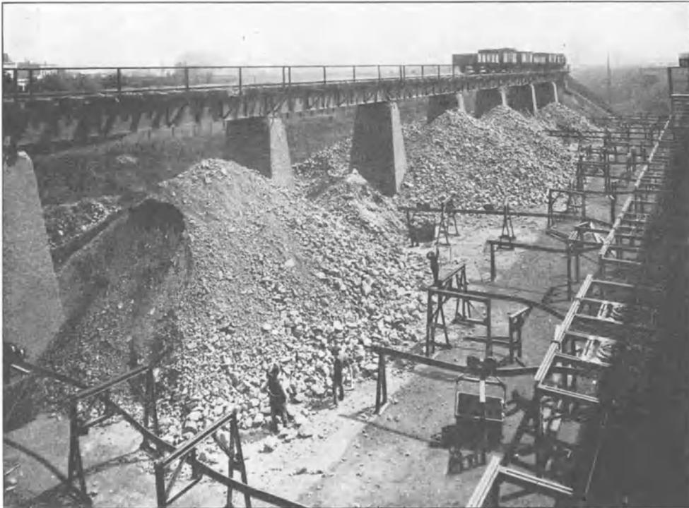
Fig. 41. Klopfen und Aufladen der Schwedenerze an Hochbahn-Lagerplatz.
