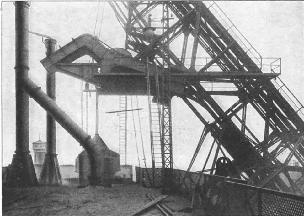
Fig. 25. Schrägaufzug Pohlig: Balancier in Senkstellung.
