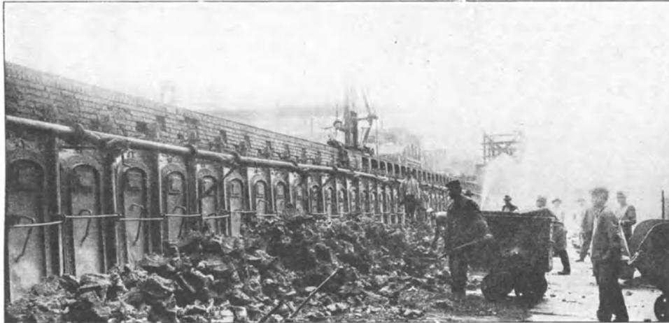
Fig. 7. Aufladen des Kokes an den Koks-batterien.
