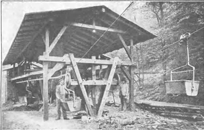
Fig. 240. Beladestation einer Einseilbahn. Bleichert.
