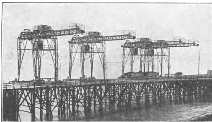
Fig. 394. Bleichertsche Krane mit verschiebbarer Fahrbahn.
