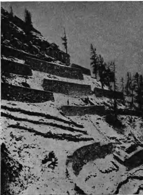
Abb. 111. Lawinverbauung durch Schneefänge an der Albulabahn.
