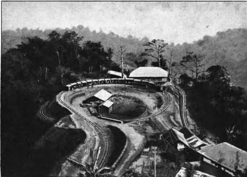
Abb. 66. Doppelschlinge der Darjeeling-Himalaya-Eisenbahn bei km 27,0.
