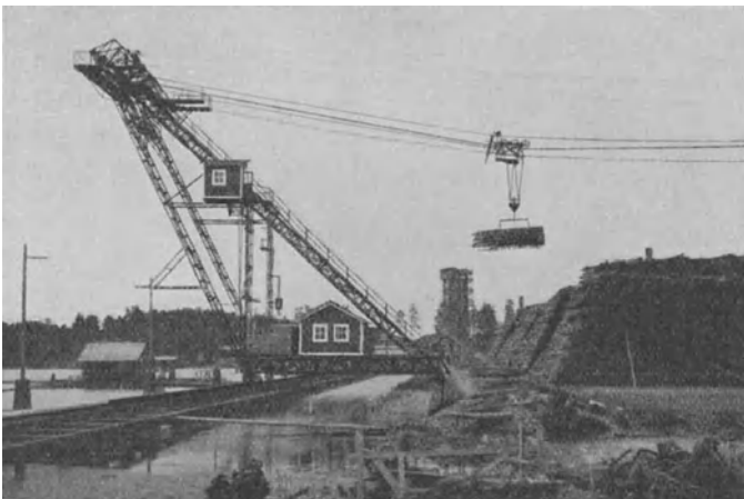
Abb. 358. Parallel fahrbarer Kabelkran für Zellstoffhölzer. Überkragender Maschinenturm zur Aufnahme der Hölzer aus dem Wasser.
