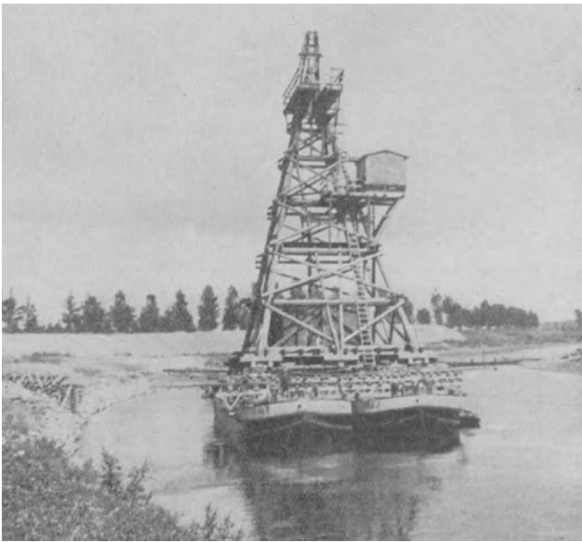
Abb. 318. Kabelkran-Holzturm beim Wechsel der Baustellen.
