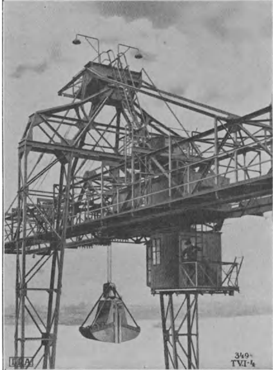
Abb. 195. Pendelstütze einer winkelbeweglichen Verladebrücke (Lauchhammer).
