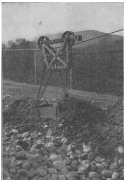
Abb. 384. Laufkatze mit Schürfkübel eines kleinen Kabelbaggers für Arbeiten in einer Kies- und Sandgrube.
