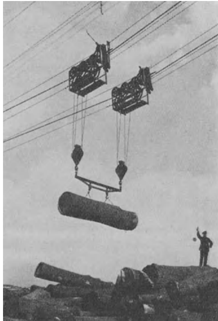
Abb. 357. Laufkatzen und Traverse eines Doppelkabelkranes zur Förderung von Holzstämmen (Bleichert).
