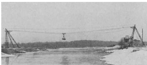
Abb. 375. Trajektkabelkran über die Ems (Pohlig). Tragkraft 8000 kg.
