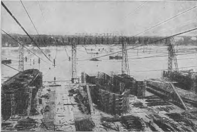
Abb. 372. Helling-Kabelkrananlage der Deutschen Werft. 24 Kabelkrane mit je 280 m Spannweite.
