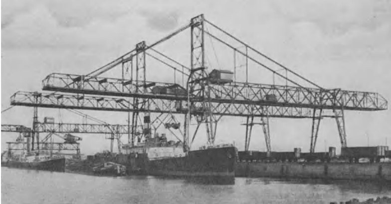
Abb. 201. Verladebrücken mit langem Ausleger für Greiferbetrieb (Demag).
