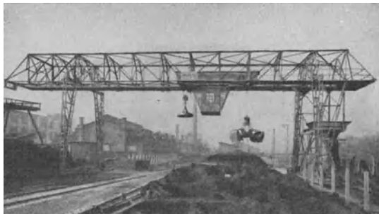
Abb. 202. Schnellfahrende Verladebrücke mit Greiferkatze und Schrottmagnet (Maschinen- und Waggonbaufabrik Simmering).
