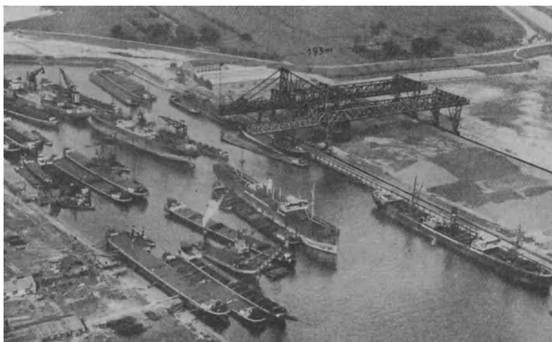
Abb. 209. Verladebrücken mit Auslegerschwenkkatze für hohe Leistungen (Demag).
