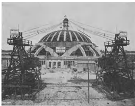
Abb. 363. Zwei kreisschwenkbare (Karussell-)Kabelkrane beim Bau einer Betonhalle.
