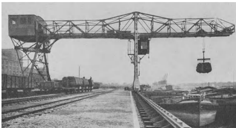
Abb. 213. Verladebrücke für Klappkübelbetrieb mit ortsfestem Windwerk (Demag).
