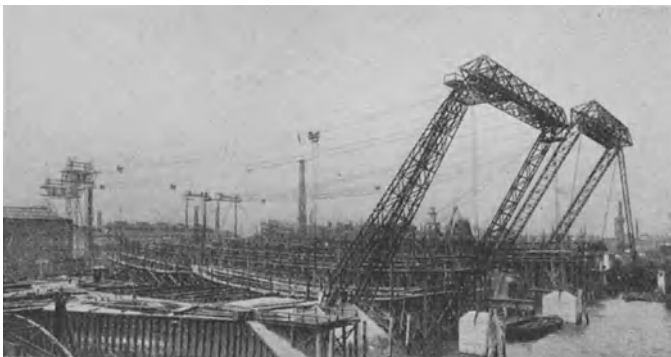
Abb 373. Helling-Kabelkrane der Reiherstieg-Werft.
