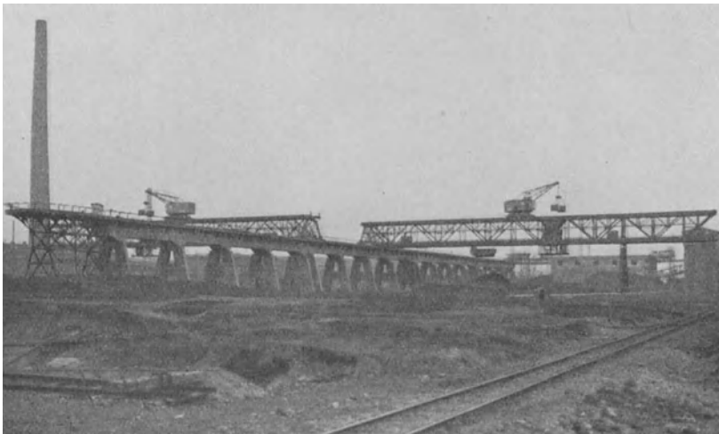
Abb. 407. Fährbare Lagerplatzbrücken der Elektrohängebahn mit Greiferdrehkranen.
