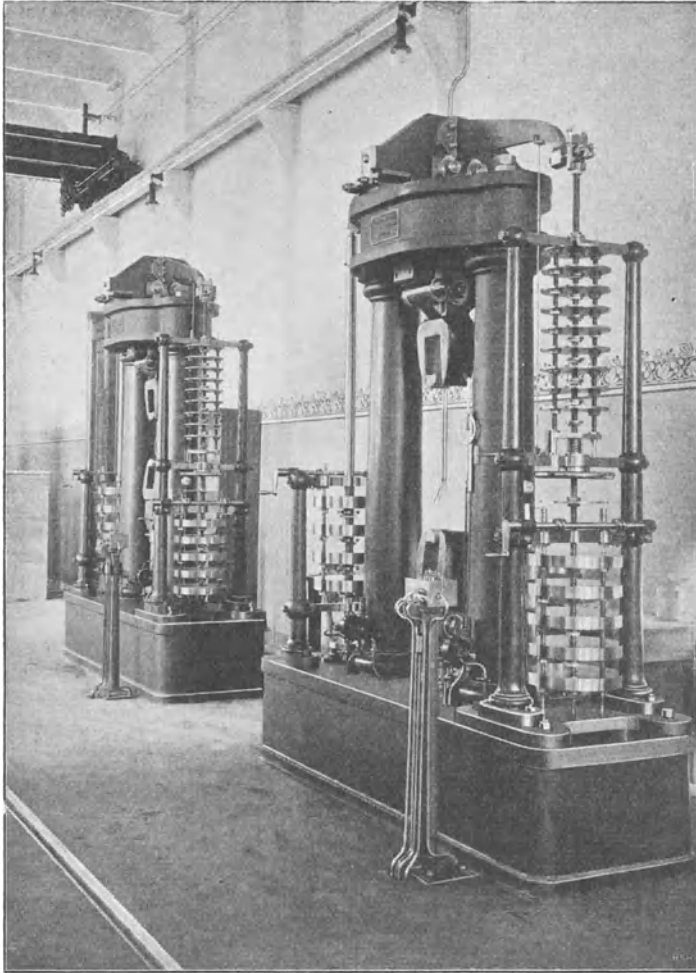
Abb. 24. Martensmaschine für 50000 kg.
