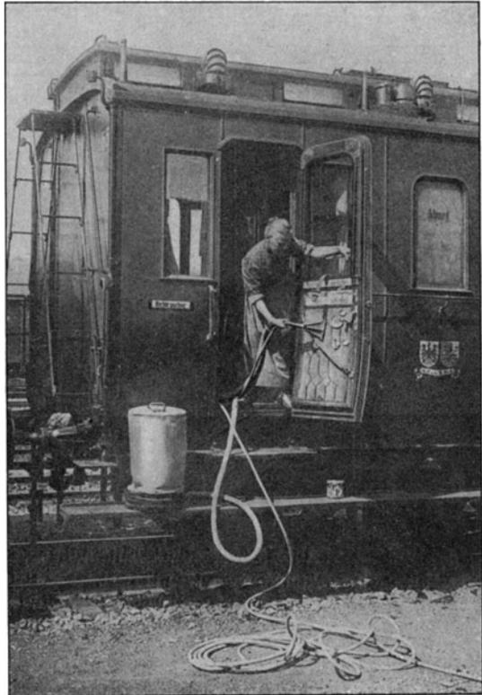
Abb. 81. Entstäubung eines Eisenbahnwagens, System A. Borsig.
