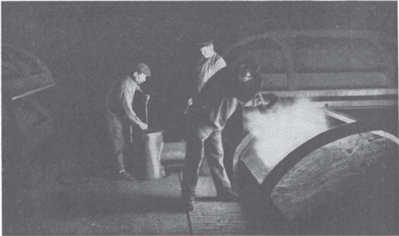
Abb. 105. Blick in eine gefüllte Kammer.
