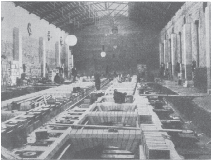
Abb.109. Ringofen im Bau.
