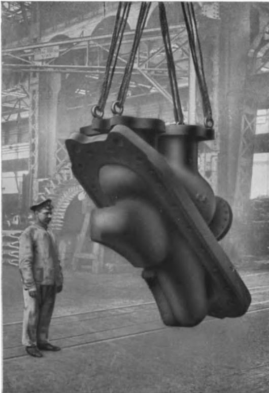
Durchbrüche in dem zylindrischen Hauptkörper und zwischen diesen beiden Öffnungen mußte eine äußerst kräftige Brücke die genommene Festigkeit wieder ersetzen. Die beiden Düsenkästen sind die einzigen Körper, welche den vollen Druck und die volle Temperatur des Frischdampfes auszuhalten haben; zugleich aber erhalten diese Körper beim Stillsetzen der Maschine plötzlich die im Kondensator herrschende Luftleere und Temperatur. Freie Dehn-
