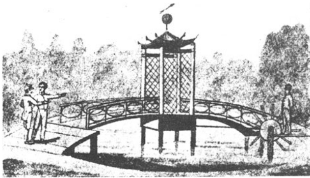
Bild 10. Brücke mit Tauchbad.
