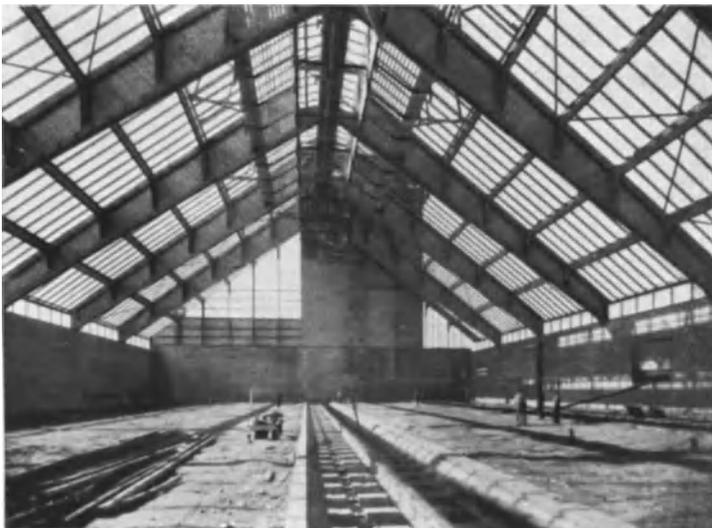
Abb. 77c. Blicke in das Innere der fertig gerichteten Halle vor der Verschalung.
