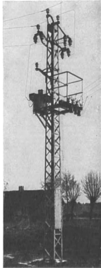
Abb. 399. Masttransformator
