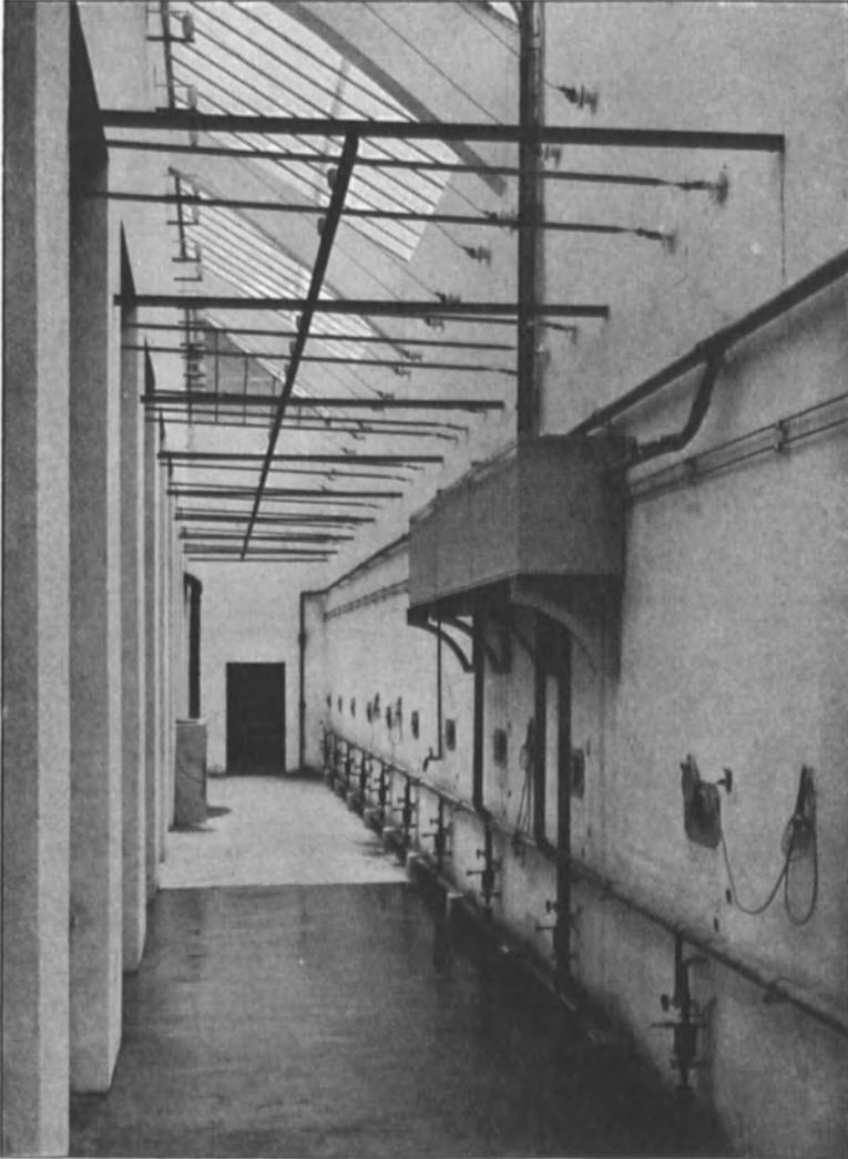
Abb. 262. Bedienungsgang zwischen Schaltanlage und Transformatorraum mit Rohrleitungen und Meldegeräten für die Wasserkühlung der Transformatoren.
