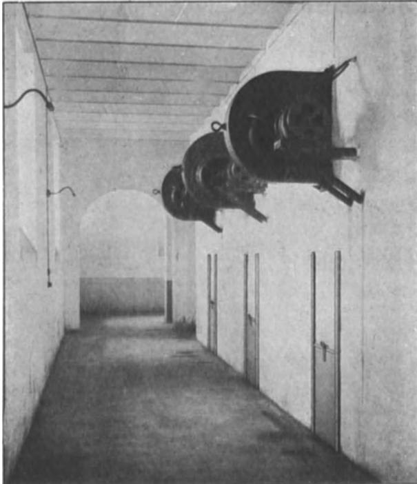
Abb. 290. Belüftung von Transformatorzellen durch außerhalb derselben angebrachte Niederdruckschleuderlüfter (120 cbm/Min. 2,5 PS).
