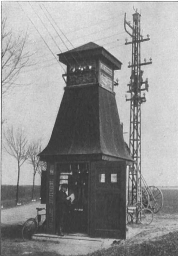
Abb. 394. Kleiner Transformatorurm mit einem Transformator.
