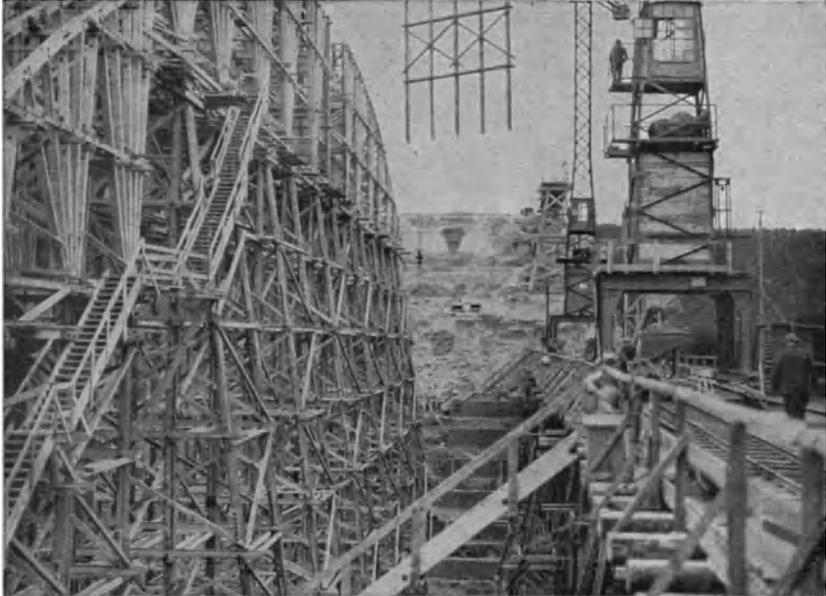
Abb. 129a. Das Lehrgerüst im Bau. (Turmdrehkrane von 28 m Nutzhöhe und 20 m Ausladung.)
