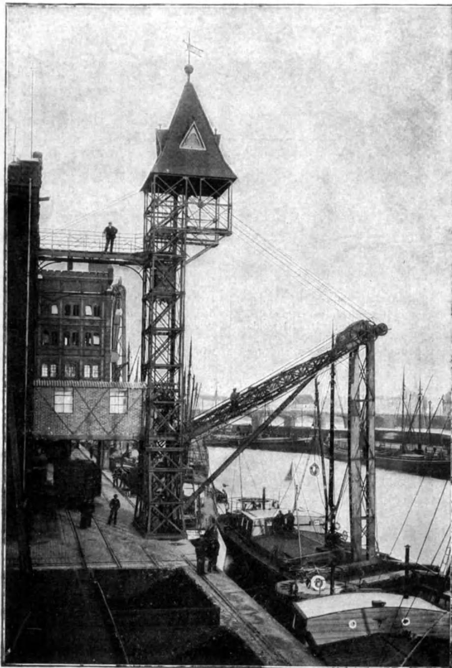
das Korn zunächst auf einen Gurtförderer im alten Lagerhaus, der es durch ein Abfallrohr nach außen auf das Brückenhaus befördert. Im Maschinenhaus wird es dem Eingangselevator zugeführt, der es einer selbsttätigen Wage (Reuther & Reisert in Hennef a/Sieg)<sup>1)</sup> im zweiten Stockwerke zu trägt. Von dort kann die Frucht den zwei großen Hausele-
