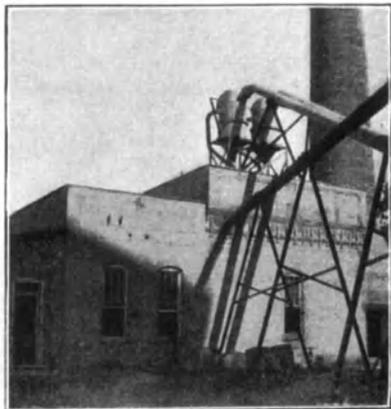
Stets wird der Staub aus den Reinigungsmaschinen zum Heizen der Kessel benutzt; charakteristisch ist für viele dieser amerikanischen Speicher das in Fig. 13 etwas größer dargestellte System von Staubrohren, die aus dem Arbeitsgebäude nach dem Dach des Maschinenhauses in eine Staubsammeltrömmel führen.
