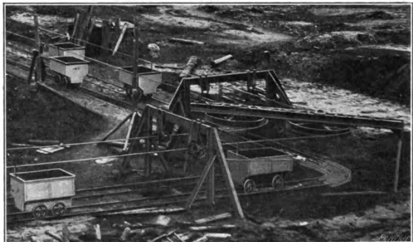
der Bahnachse aus gesehen befindet sich das eine Wagenhänge ( $c_1$ ) außerhalb ( $l$ ), das andre ( $c_2$ ) innerhalb der beiden Laufbahnen ( $r$ ); dadurch ist es möglich, bei Anwendung eines unterhalb der Laufbahn liegenden Zugseiles Krümmungen ohne Lösen der Wagen vom Zugseil zu durchfahren<sup>1)</sup>.
