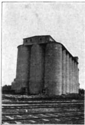
Schicht hart gebrannter Ziegeln ummauert, wie das bereits an dem unteren Teil der »Kuppel« zu sehen ist. An der langen Seitenwand sind die Anfänge der Verladefallrohre bereits zu erkennen.
