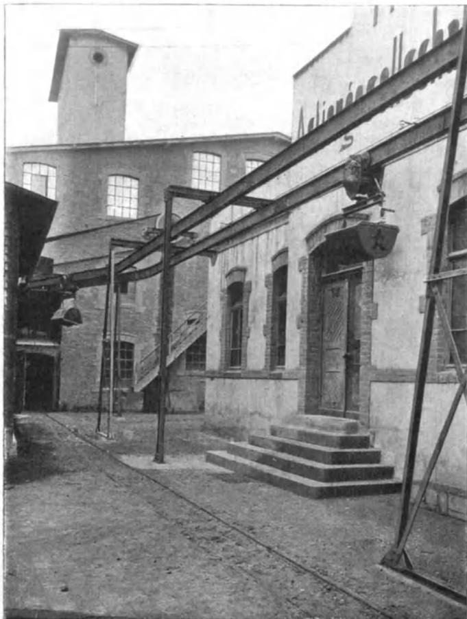
entwickelt. In »Stahl und Eisen«<sup>1)</sup> sind mehrere solcher Anlagen abgebildet. Im Verein mit den dort wiedergegebenen Einzeldarstellungen des Wagens (siehe auch Fig. 26 und 27) dürfte die Art des Betriebes ohne weiteres verständlich sein. Die Länge einer derartigen von W. Fredenhagen in Offenbach gebauten Bahn, Fig. 28, beträgt rd. 220 m; jeder Wagen benötigt bei 0,2 cbm Füllung und 1,5 m Sekundengeschwindigkeit rd. 0,5 PS, und dabei belaufen sich die Kosten der Anlage auf etwa 8000 M.
