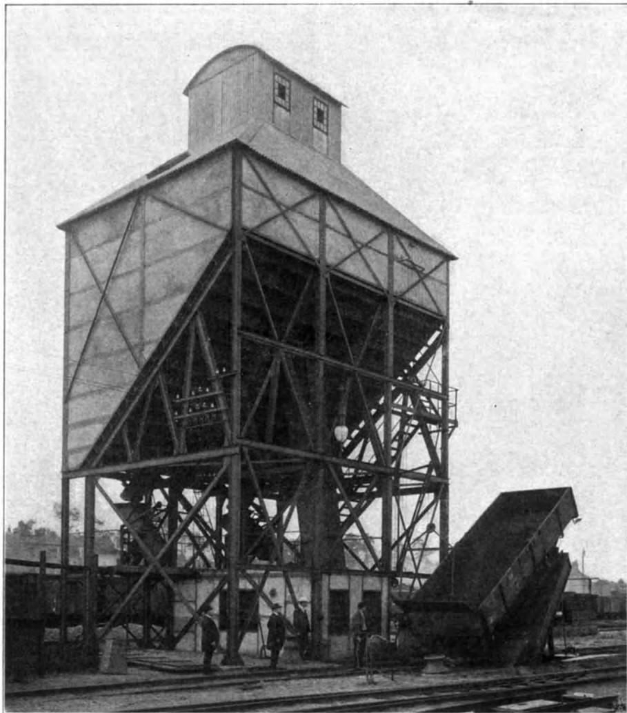
Der Kohlenzug wird durch die Lokomotive bis vor den Kipper geschoben, und die der Kippbühne zunächst stehen-
