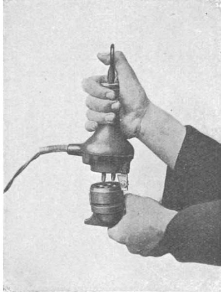
Abb. 229. Ansicht des Schießschalters der Siemens-Schuckertwerke.
