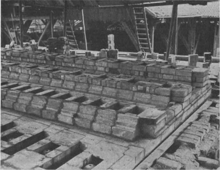
Abb. 70. Bau der Versuchsanlage Dr. Otto & Co., Dahlhausen a. d. Ruhr 1914.
