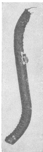
Abb. 1. Deckendurchführung. Schutzrohr nach \frac{3}{4} Jahren durchgerostet.
