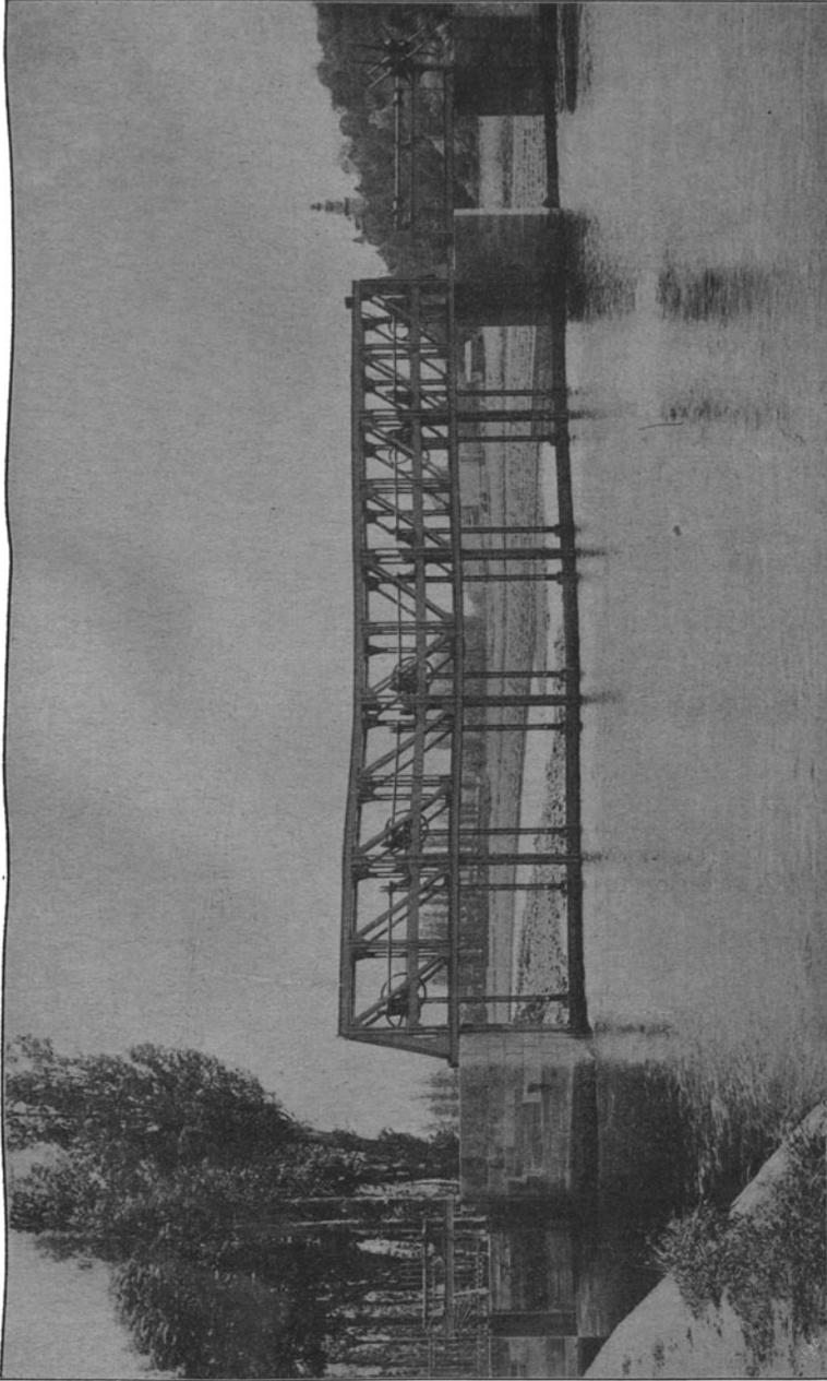
Fig. 16. Schützenwehr, ausgeführt von Gebr. Benckiser (jetzt W. Luig, Illingen). 5 Tafeln zu 4 m Breite und 1,35 m mittlerer Stauhöhe.
