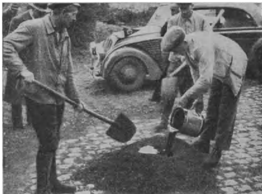
Abb. 62. Mischen des Kaltteeres mit dem Zuschlag aus Gesteinsplitt beim Straßenbau.
