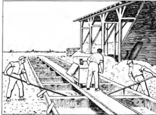
Abb. 18. Kalklöschen: Durch das Löschen des Kalkes (Übergießen des Branntkalks mit Wasser) wird unter Wärmeentwicklung Kalkhydrat gebildet (Wasseranlagerung).
