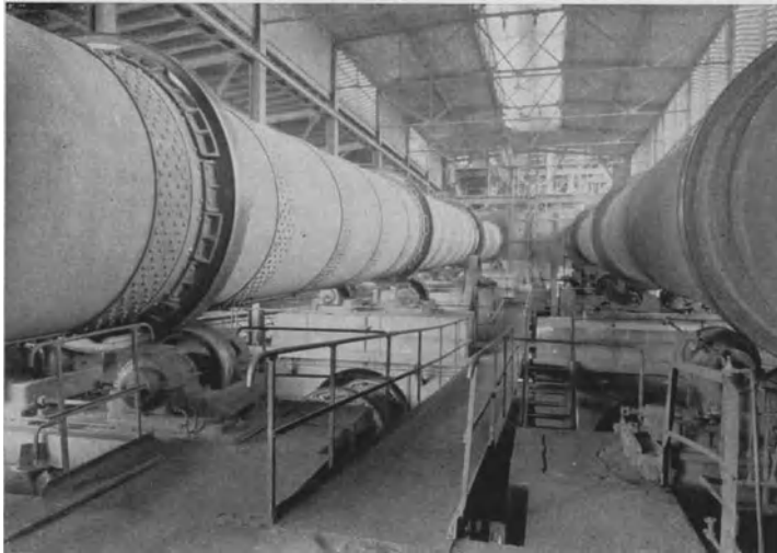
Abb. 23. Drehofen zur Herstellung von Zement: Das Rohmehl (Mergel oder Mischung von Hochofenschlacke und Kalkstein) wird am hochgelegenen Ende des Ofens aufgegeben und durchläuft das sich langsam drehende Rohr. Am unteren Ende wird eine Flamme aus Kohlenstaub eingeblasen. Hierdurch wird zunächst die Kohlensäure ausgetrieben, danach sintert das Rohmehl zu Klinker.
