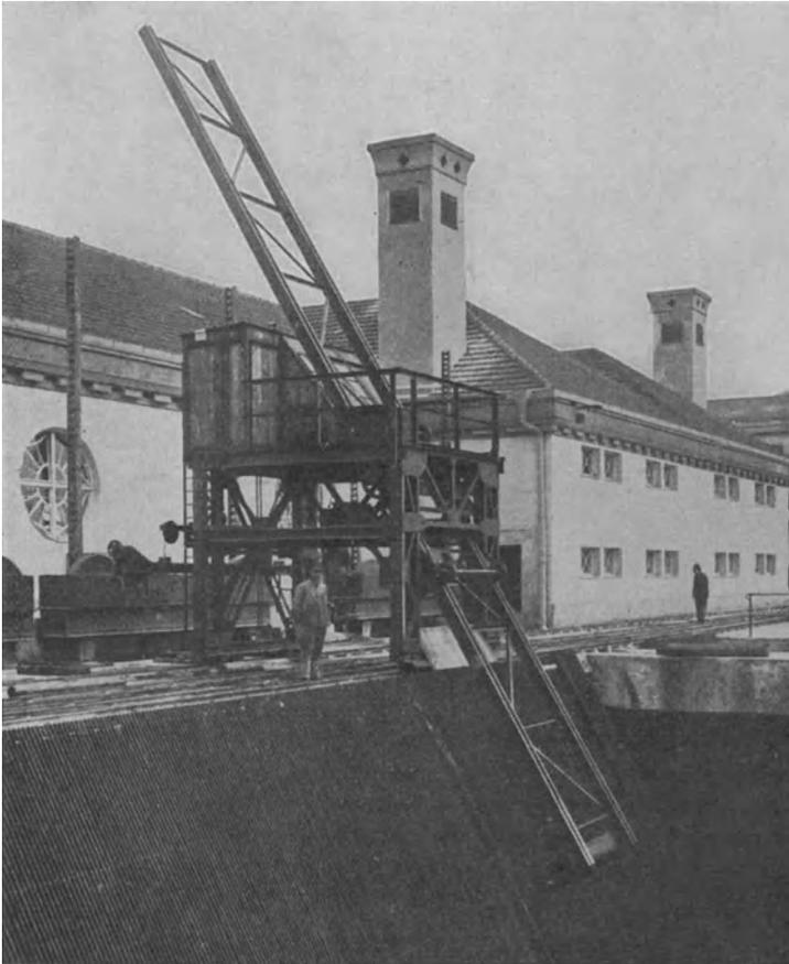
Abb. 43. Rechen-Reinigungsmaschine der M A N.
