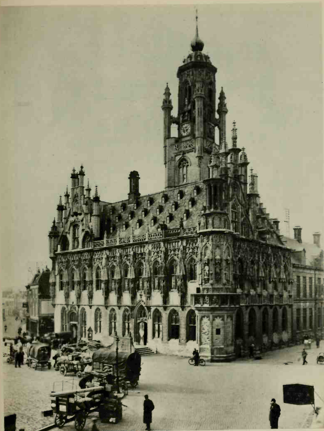
31. Middelburg: Town Hall (xv century) Middelbourg: L'Hôtel de Ville (xve siècle)
