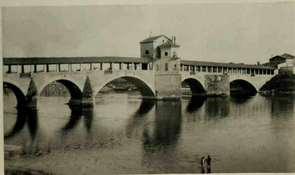
202. Pavia: Bridge over the Ticino (xiv-xvi century) Pavie: Pont sur le Tessin (xive-xvie siècle)
