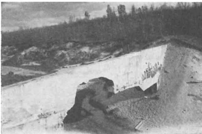
Abb. 322. Grundbruch am Langewald-Damm bei Chicopee, Mass. (nach Terzaghi)
