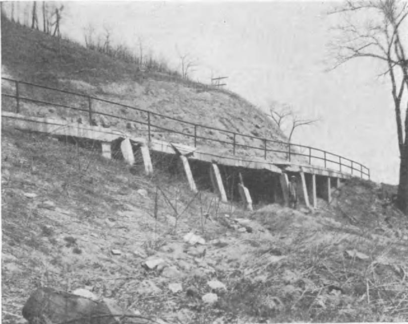
Abb. 256. Abfließen des lehmigen Bergschuttes unter einer Betonstraße. (Aufnahmen des Bureau of Public Roads, Washington, D. C.)
