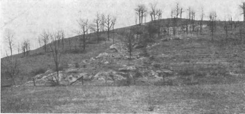
Abb. 254. Rutschung im lehmigen Bergschutt. (Aufnahme des Bureau of Public Roads, Washington, D. C.)
