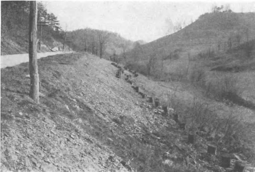
Abb. 258. Bekämpfung der Schuttrutschungen durch Eintreiben von Pfählen oder Stahlröhren
