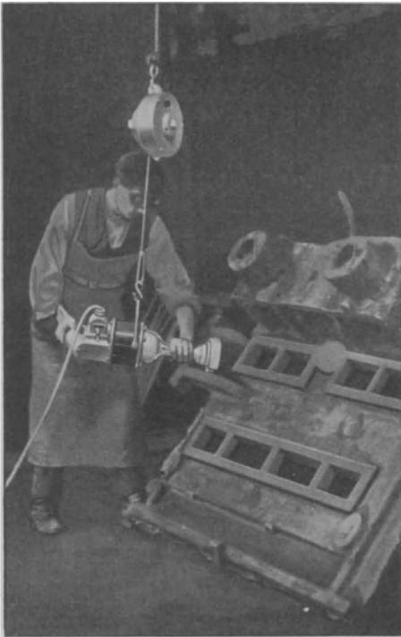
Abb. 66. Gußputzen mit Handschleifmotor am Seilzug.
