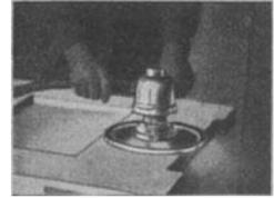
Abb. 124. Winkelkopf zum Holzschliff beim Schleifen von Türrahmen.
