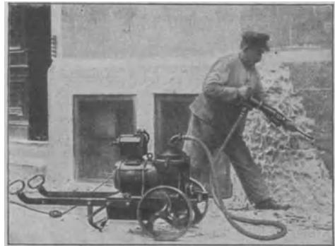
Abb. 164. Abspitzen von Mauerwerk durch einen Steinmetz.
