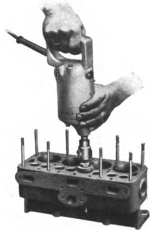
Abb. 48. Einschleifen der Ventilsitze mit Profilscheibe.
