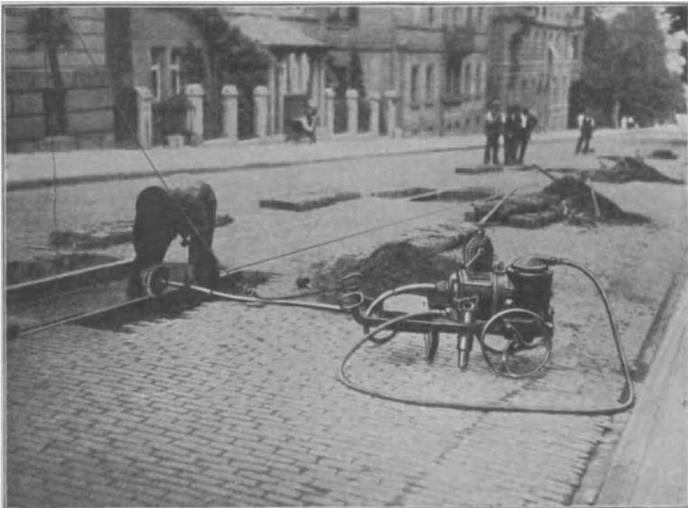
Abb. 151. Übersleifen von Schienenstößen.
