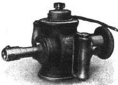
Abb. 16. Handbohrmaschine für Gleichstrom aus dem Jahre 1895.
