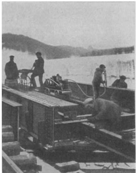
Abb. 142. Antrieb durch Verbrennungsmotor.
