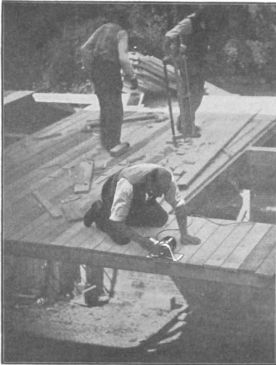
Abb. 82. Anwendung der Motorhandsäge auf dem Zimmerplatz.
