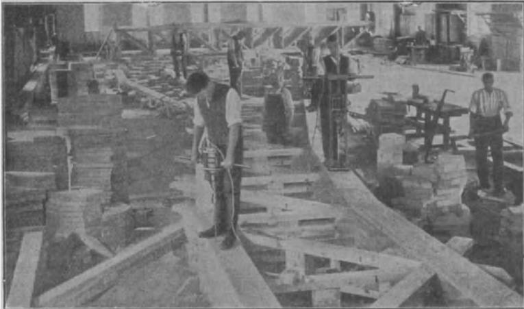
Abb. 34. Holzbohren aus freier Hand und im Bohrständer beim Bau von Dachbindern.
