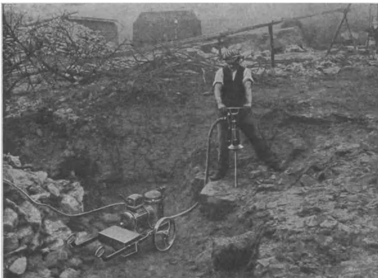
Abb. 157. Einschlauchgesteinsbohrhammer.
