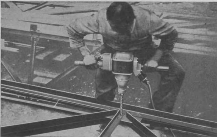
Abb. 39. Auftreiben von Nietlöchern an einer Eisenkonstruktion.
