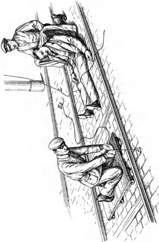
Abb. 158. Hilfeleistung bei einem durch elektrischen Strom Verunglückten. Ableitung des Stroms: Ende  $E_1$  wird von dem auf einem isolierten Brett knieenden Samariter in die Erde geführt, Ende  $E_2$  dann auf den die Schädigung verursachenden Leitungsdraht ( $L$ ) gebracht, von dem so die Elektrizität nach der Erde abgelenkt und unschädlich gemacht wird.
