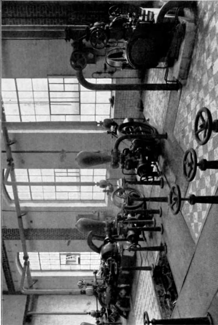
Abb. 160 b. Innenansicht der Impragnieranstalt Ohlau (Raum fur Ol- und Luftpumpen).
