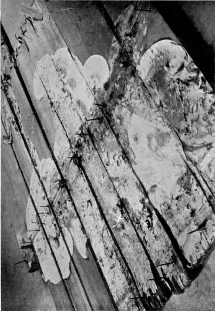
Abb. 53. Die Ausbreitung des Myzeliums von *Merulius domesticus* unter der Dielung eines Zimmers im feuchten Unterdienraum. Bei  $\times$  Fruchtbildung.
