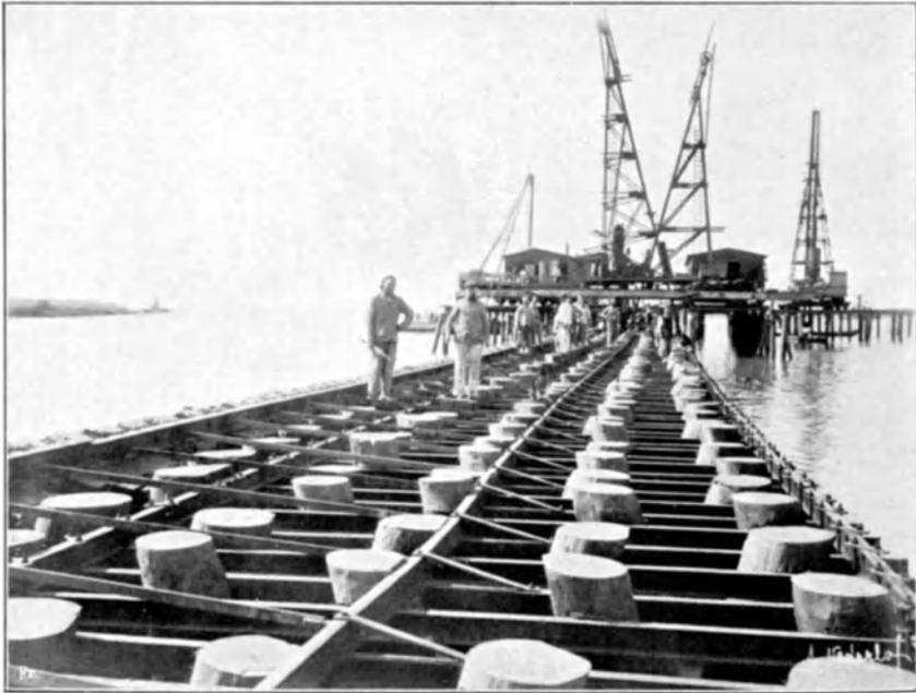
Abb. 197 b. Kaimauer in Tsingtau; Blick auf die Pfahlköpfe des hölzernen Pfahlrostes.
