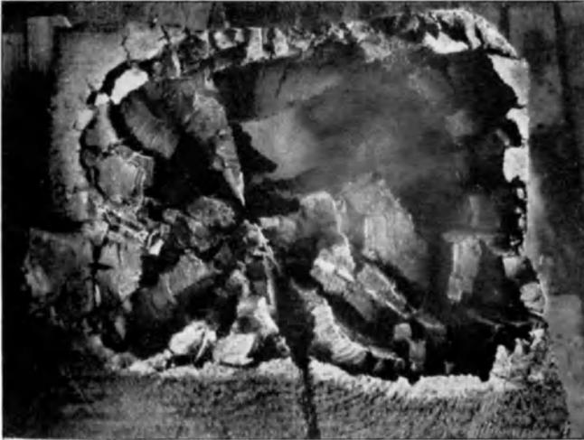
Abb. 58. Innere Holzdestruktion eines Ständers durch *Domesticus* von der Hirnfläche ausgehend. Aus einem Mansardengeschoß. Verkl.
