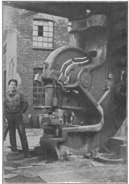
Abb. 197. Schweißung des Balanziers einer Schiffbaustanze.
