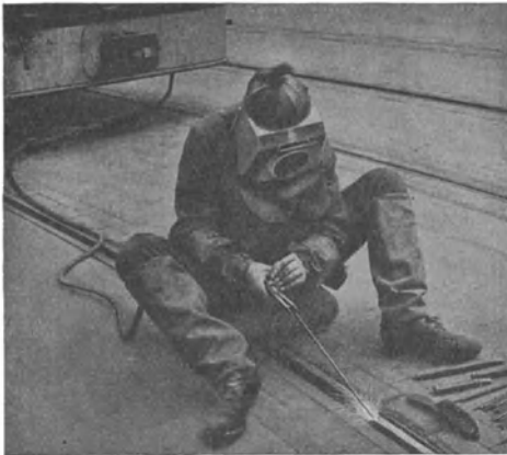
Abb. 140. Schweißer mit Schweißgerät (beim Schienenaufschweißen).
