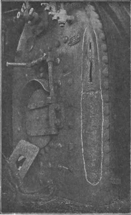
Abb. 179. Lokomotivkessel, halbfertig geschweißt.
