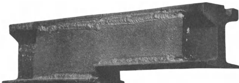
Abb. 175. Geschweißter Übergangsstoß zweier Rillenprofile.
