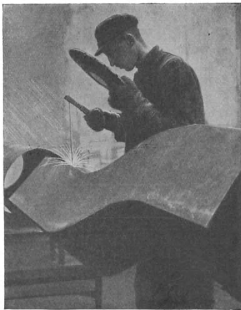
Abb. 160. Schweißung eines Ventilationschachtes.
