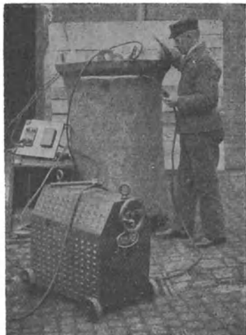
Abb. 184. Schweißen von Rissen an Glühköpfen.
