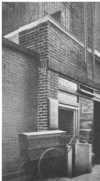
Abb. 22. Feuerleiter auf die Straße mündend. Von der Umfassungsmauer der zum Erdgeschoß führenden Treppe kann die hochgezogene Feuerleiter leicht erreicht werden.
