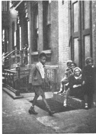
Abb. 23. Im Hintergrunde ein noch ungedeckter Lichthof. Im Vordergrund der Rost eines gedeckten Lichthofes.
