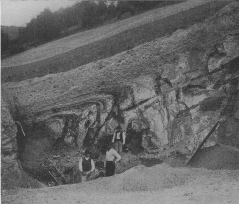
Abb. 23. Hangfließen im zersetzten Elbogener Granit bei Stirn an der Eisenbahn Schönwehr-Elbogen, C. S. R.
