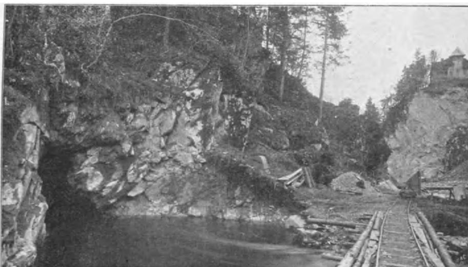
Fig. 137, Textbl. 2, zeigt die Gründung der Ennepetalsperre im Juli 1902. Die am rechten Talhang in mehreren Terrassen ausgeführten Steinbrüche gestatteten eine vorzügliche Zufuhr des Steinmaterials zur Baustelle. Der Felsen war ausgezeichnet geschichtet, so daß sich das Mauerwerk hier in sehr günstiger Weise hineinsetzen konnte. Auch hier ist die Ennepe über die ziemlich breite Baugrube hinübergeführt.
