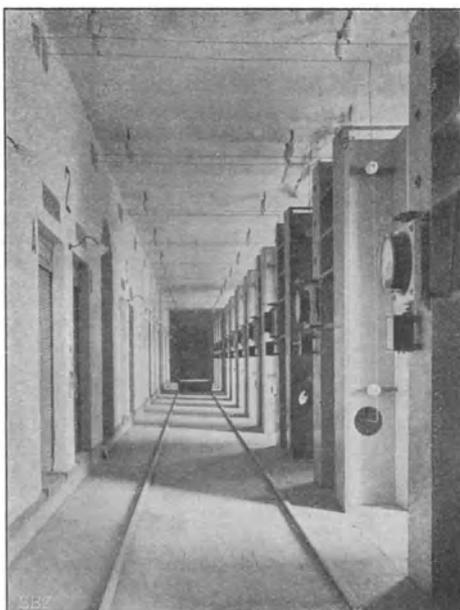
Fig. 236. Aufbau einer Hochspannungsschaltanlage (links die Transformatoren in abgeschlossenen Zellen; rechts die Zellenanlage für die Hochspannungsapparate und -leitungen; Meßinstrumente bei den Zellen; Transportgleise für die Transformatoren; Beleuchtung).
