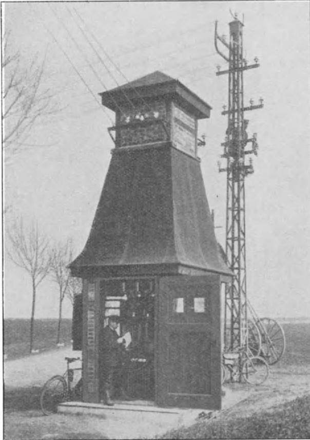
Fig. 244. Kleiner Transformorturm mit einem Transformator.
