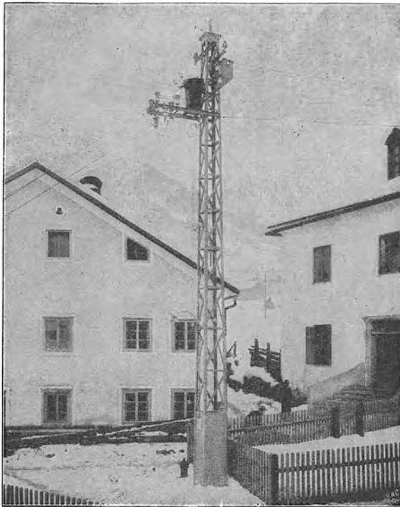
Fig. 271. Masttransformatorstation mit Eisenmast innerhalb eines Dorfes.
