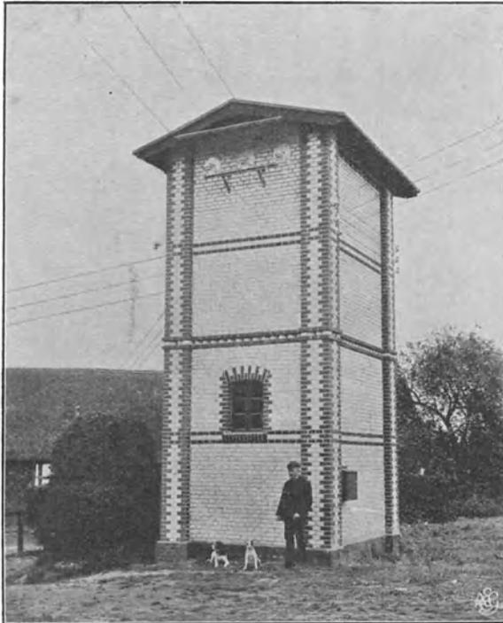
Fig. 240. Transformatorurm für Überlandzentralen.
