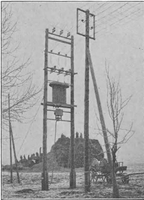
Fig. 268. Masttransformatorstation auf dem Felde.
