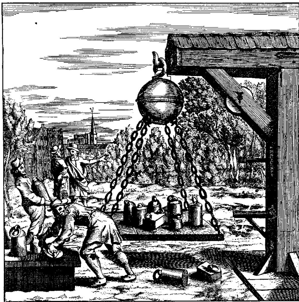
Оттягивание грузомъ висящихъ магдебургскихъ полушарій
